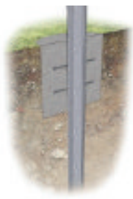
Забивання із бетонуванням
