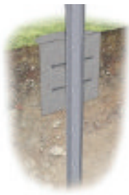
Забивання із бетонуванням
