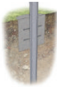
Забивання із бетонуванням
